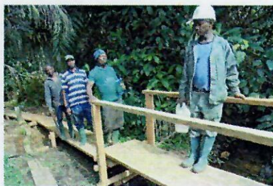
Passerelle en bois construite par CEW sur une piste inondable menant au Rocher UM NYOBE
