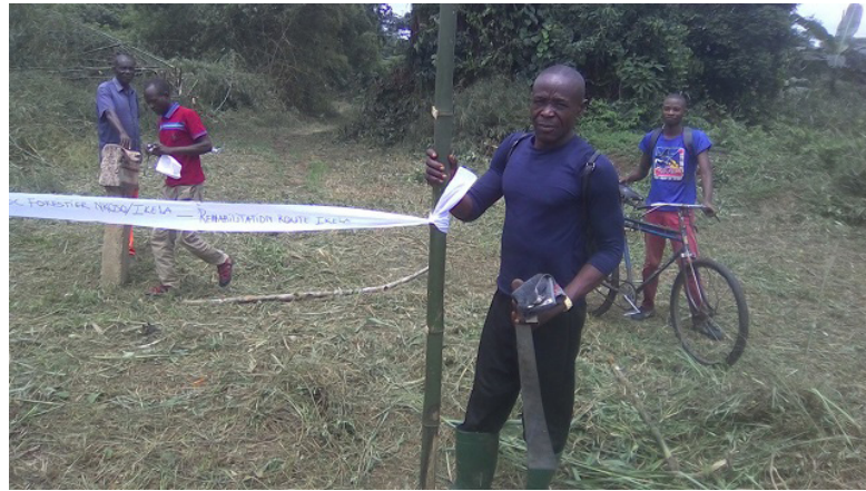
Photo 8. Travaux de réhabilitation de la route Ikela. © GACEBB
